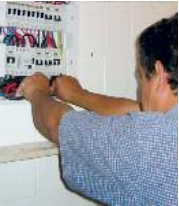
Instalações devem ser executas por profissionais capacitados
