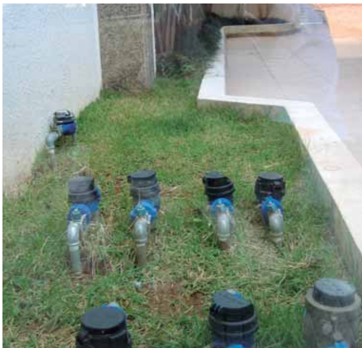
Utilização de hidrômetros individuais agora é lei para novas edificações
