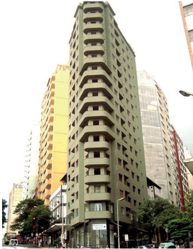
Retrofit é uma opção para atualizar edificações antigas
