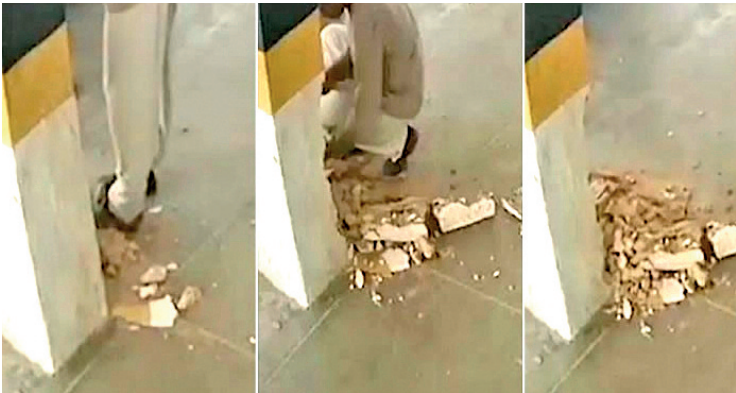
Imagens mostram pedreiro trabalhando nos pilares antes do desabamento
