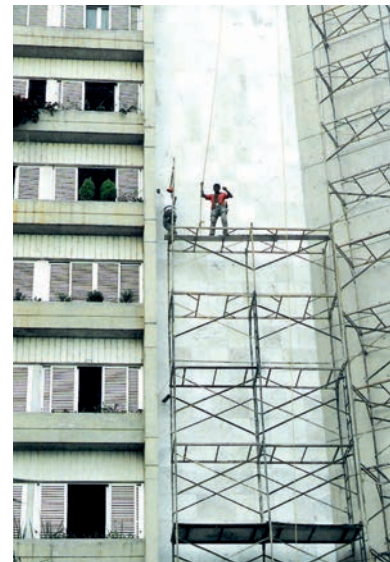
Construtora tenta se eximir de executar reparos necessários
