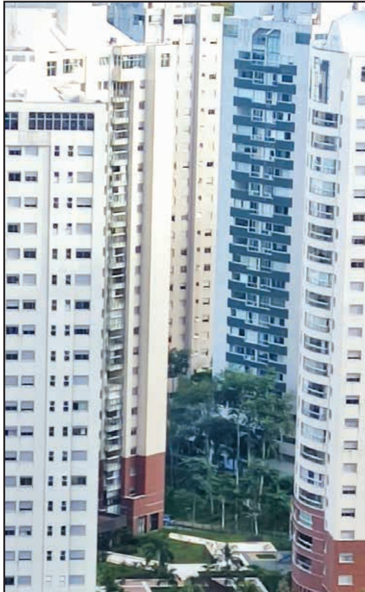
Nos condomínios existem sistemas que devem ser checados periodicamente
