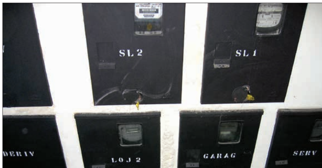
infiltrações comprometem a segurança da edificação
