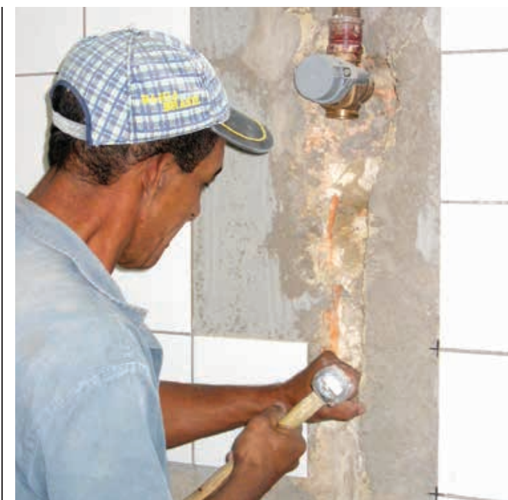
Alterações em tubulações devem constar do projeto de reforma das unidades
