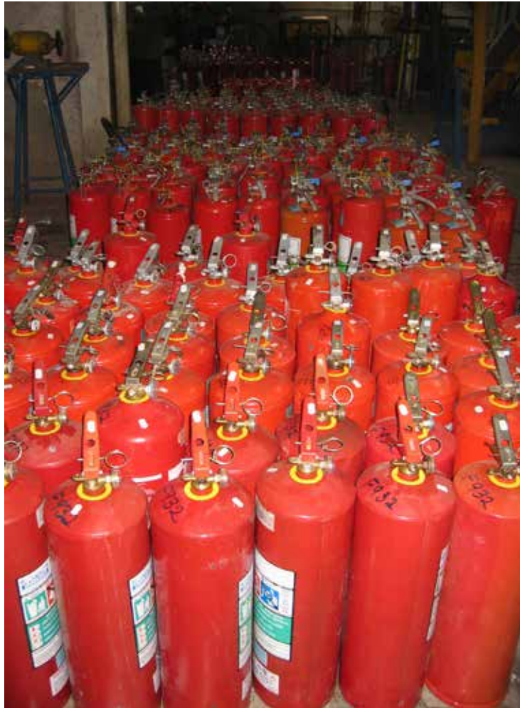
Extintores devem passar por manutenções periódicas
