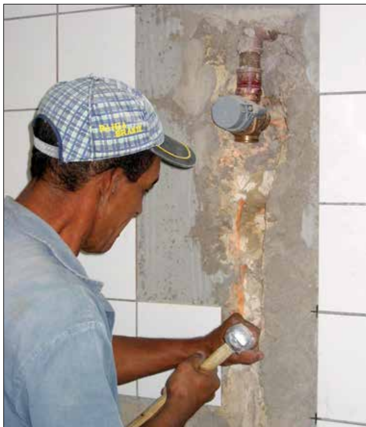
Casos como troca de tubulações devem ter o acompanhamento de um responsável técnico
