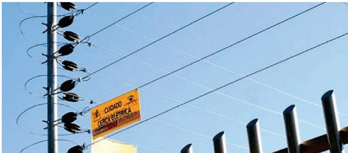
drada na categoria de equipamentos protetores de perímetro, ou seja, faz a segurança dos limites do terreno do prédio, sendo instalada, portanto, nos muros. O mercado de utilidades para incrementar a segurança predial inova a cada dia e atualmente há diferentes tipos de cercas elétricas disponíveis, com marcas e modelos trazendo novas funcionalidades, contudo o princípio de funcionamento permanece o mesmo: usar a eletricidade
