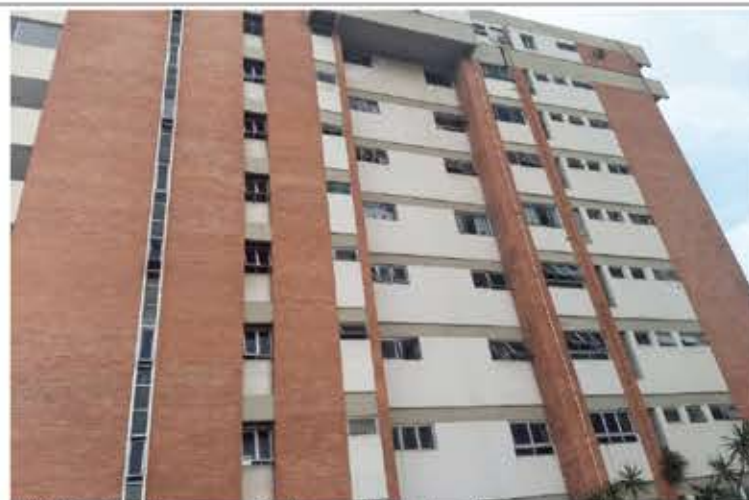
■ A justiça determinou a remoção do ar condicionado em área inadequada
