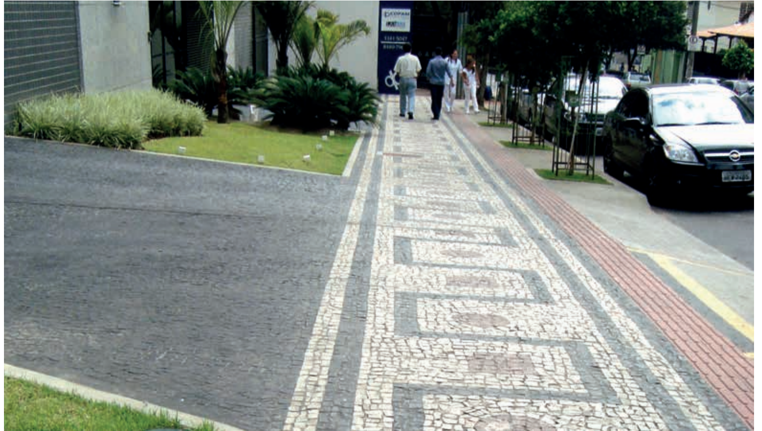
Conservação das calçadas garante a segurança de pedestres
