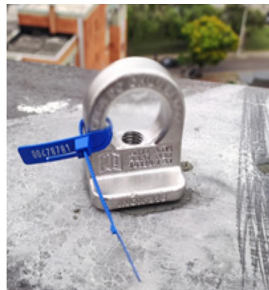
Cada dispositivo de ancoragem deve ser submetido a uma inspeção periódica a cada 12 meses, a fim de manter o controle, acompanhamento e segurança do dispositivo. (Referências: NR 18, NR 35, NBR 16235-1 e NBR 16325-2)
