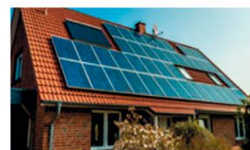
ENERGIA SOLAR FOTOVOLTAICA
