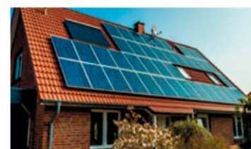
ENERGIA SOLAR FOTOVOLTAICA
