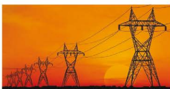
INSTALAÇÕES ELÉTRICAS EM MÉDIA E ALTA TENSÕES
