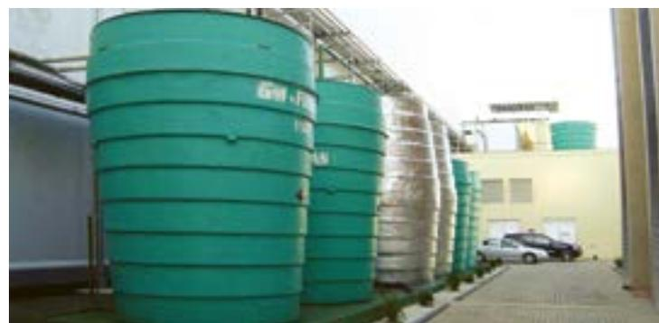
por um preço acessível: a parte interna é completamente lisa, o que facilita a manutenção e a limpeza e dificulta o acúmulo de sujeira nas laterais. A parte exterior conta com proteção ultravioleta, impedindo a alteração da superfície mesmo sob condições climáticas muito quentes. Além dos cuidados na escolha da caixa d'água, bem como na sua
