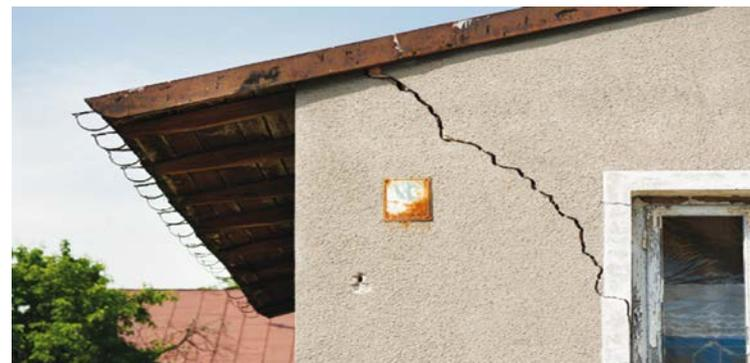
Fissuras, trincas ou rachaduras são nomes diferentes para um mesmo incidente observados e que deve servir de sinal de alerta, pois não revela algo bom. Trata-se de uma consequência decorrente do excesso de tensões sobre um determinado material e isso nunca deve ser negligenciado. É importante fazer o monitoramento contínuo dessas falhas. Uma dica é colocar selos de gesso, argamassa ou lâminas de vidro sobre as trincas e colocar data. Outra maneira de acom-
