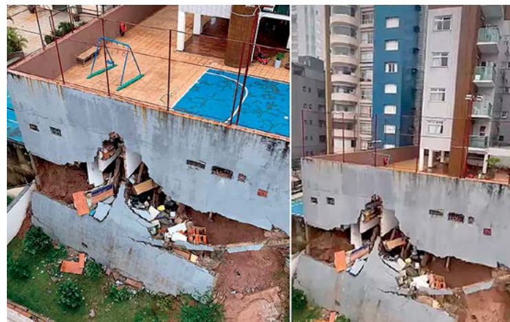
Vídeo: parte de prédio desaba em Belo Horizonte | Bandjornalismo
