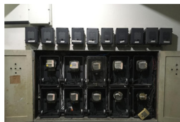
MODERNIZAÇÃO DE PC'S E AUMENTO DE CARGA
