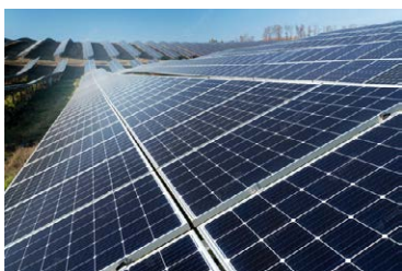
ENERGIA SOLAR FOTOVOLTAICA
