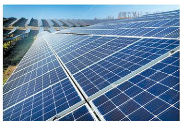
ENERGIA SOLAR FOTOVOLTAICA
