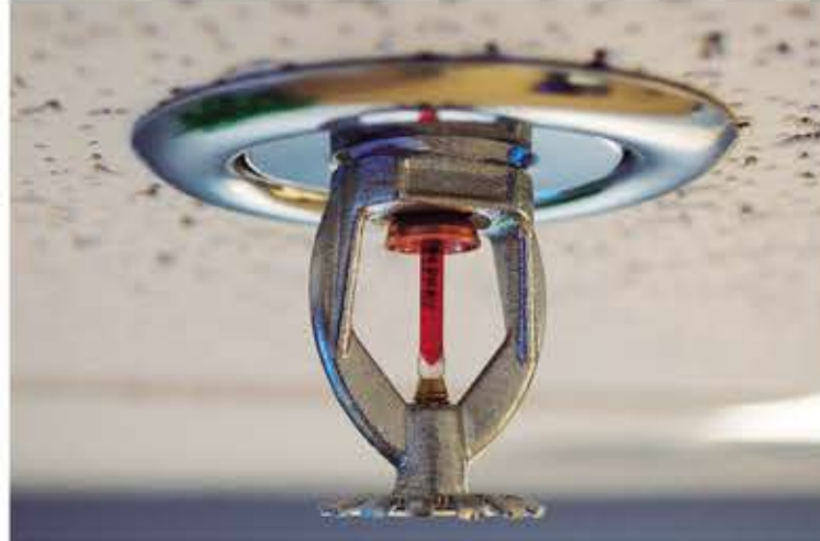
■ A NBR 10897: 2014 é a que regulamenta a instalação dos sistemas de chuveiros automáticos
