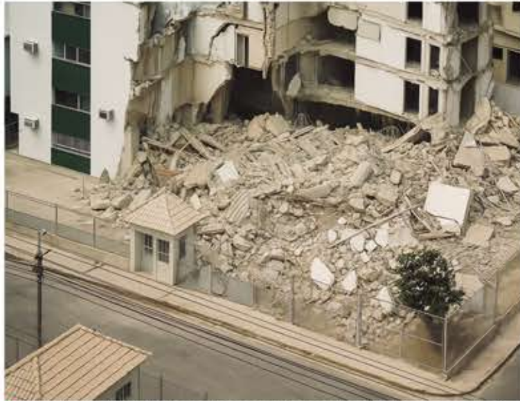
■ A falta de manutenção é uma das maiores causas de colapso em edificações no Brasil
